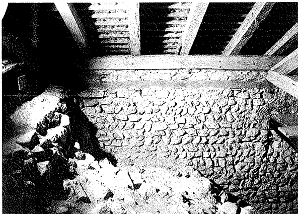
Abb. 10: St. Georg, östlicher Teil der Seitenschiffnordwand. Aus statischen Gründen erneuertes Mauerwerk im Ährenverband. Blick vom Dachboden des nördlichen Seitenschiffs.
