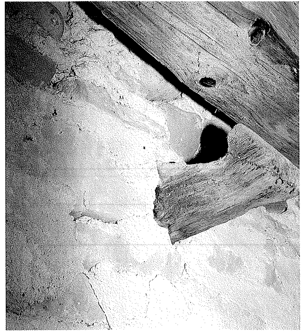
Abb. 2 (links): St. Georg, Innenansicht. – Abb. 3 (rechts): St. Georg, nördliches Seitenschiffdach. Im Mauerwerk der Mittelschiffnordwand eingebundene Konsole als ehemaliges Auflager für den Streichbalken des Seitenschiffdaches (Nov. 1994).
