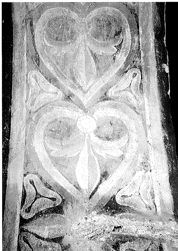
Abb. 8: St. Georg, Mittelschiff. Nordseite: Arkaden- bogen (Untersicht) mit weißem Schimmelbelag.
